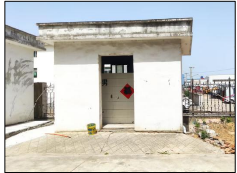
厂区现有卫生间
